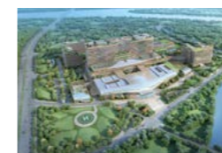
和祐国際病院 陽子重粒子センター 中国仏山市 (建設中)
