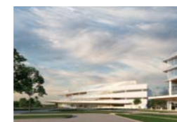
メイヨークリニック ジャクソンビルキャンパス 米国フロリダ州ジャクソンビル (建設中)
