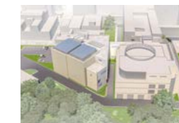
筑波大学附属病院 陽子線治療センター [追設] 茨城県 (建設中)
