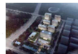
徐州陽子重粒子病院 中国徐州市 (建設中)
