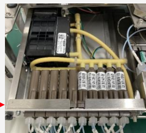
デガッサユニット電源部
