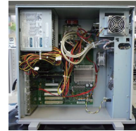
監視端末内部
