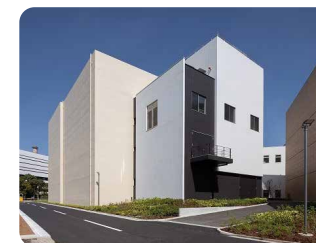
陽子線治療センター外観
