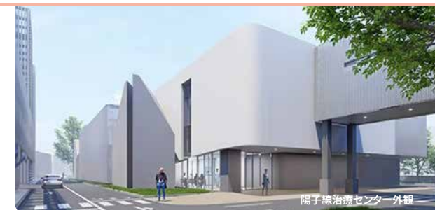
陽子線治療センター外観
