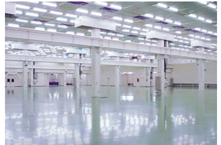
大型クリーンルーム Expansive clean room
