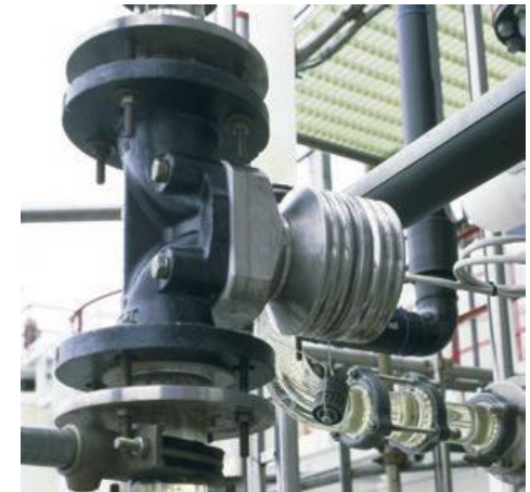
屈折率計センサ 据付例
