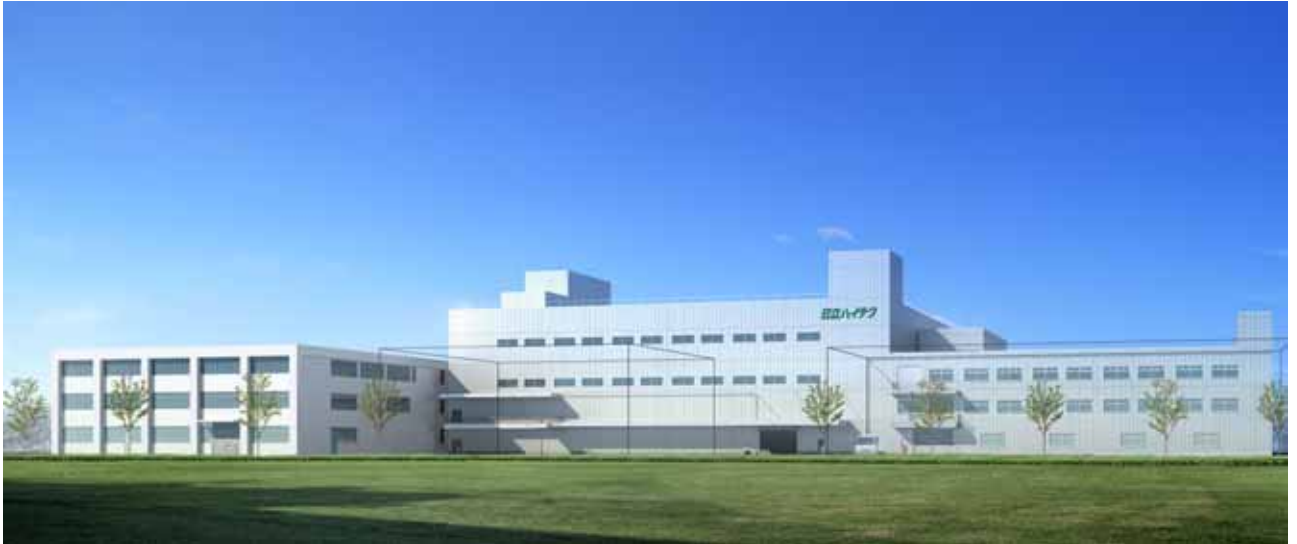
埼玉事業所 新C棟 (中央の建屋が新C棟)
