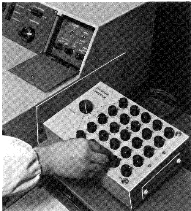
図23 カーベチャコレクタおよび付属装置
