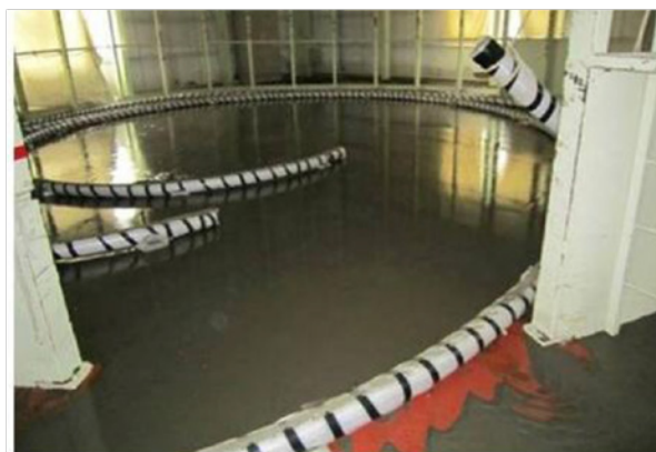
図4 完成直前で津波を受けた高電圧ケーブル
