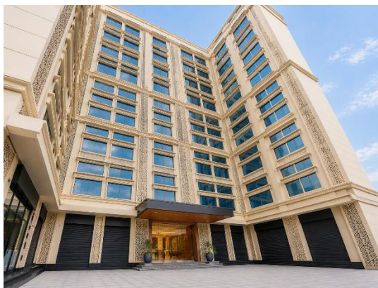
「Advanced Technology Innovation Center Mumbai(ムンバイラボ)」が入居するビル外観
